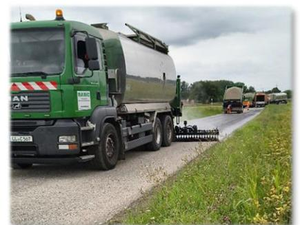
vier Wochen wurde der überschüssige Splitt mittels Kehmaschine entfernt. Mit dieser Sanierung konnte die Lebensdauer der Straße um rund 8 bis 10 Jahre verlängert werden.
